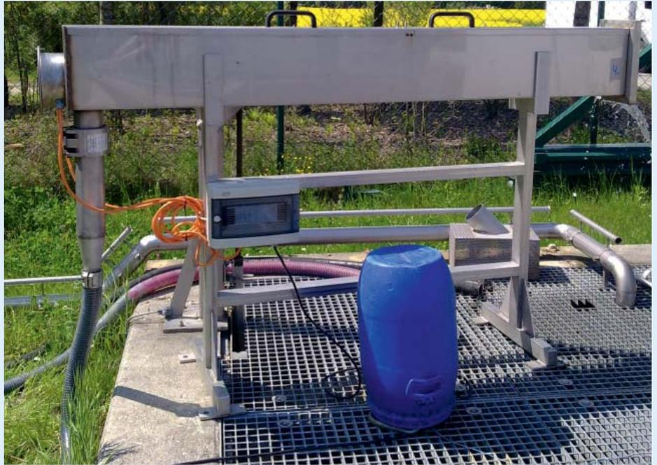
UV-EINHEIT zur Desinfektion des gereinigten Abwassers
