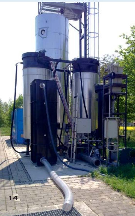
(Fixed Bed Filter Blocks). Auf eine sonst übliche Schlammrückführung in den biologischen Reaktor kann bei dieser Technologie vollständig verzichtet werden.
